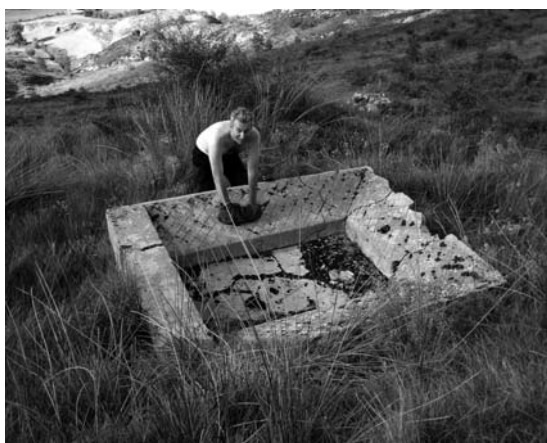
Figura 9.- Lavadero de ropa de cemento, en un campamento nacional a cuatro kilómetros del frente. Guadalajara.
