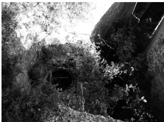
Figura 8.- Aljibe hecho con una tinaja de barro empotrado en un elemento de resistencia de hormigón, ejército nacional. Guadalajara.
